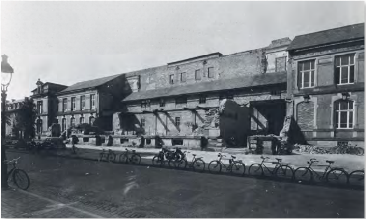
▲ Abb. 54 Stark zerstörte Aula (heute Architekturgebäude) der Technischen Hochschule Karlsruhe, deren Wiederaufbau sich bis in die 1950er Jahre zieht, um 1950
