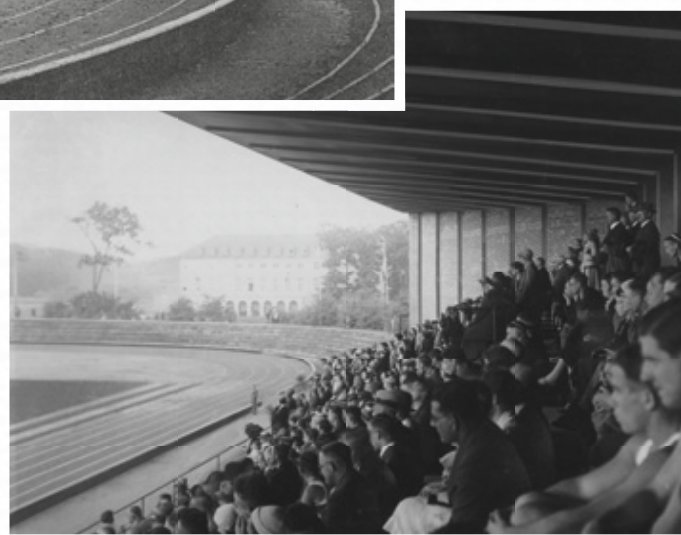
▶ Abb. 26 Blick von der Zuschauertribüne des Hochschulstadions auf das Studentenhaus, 1935
