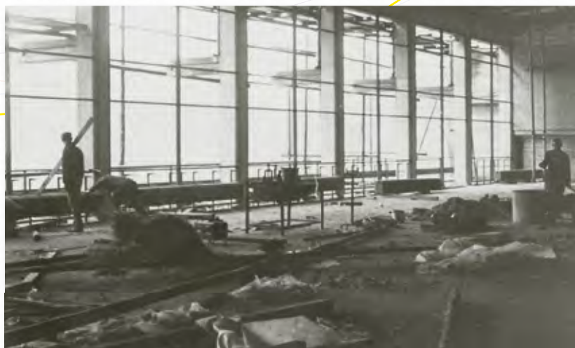
▲ Abb. 101 Speisesaal des Mensa-Anbaus im Bau, 1960/61
