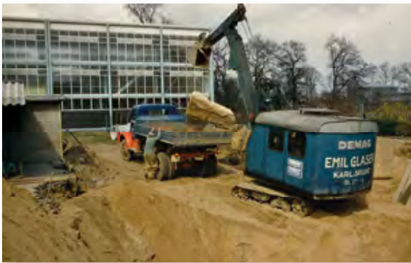
▲ Abb. 72 Einbau einer neuen Heizung ins Studentenhaus im Jahr 1958, im Hintergrund das neue Versuchskraftwerk
