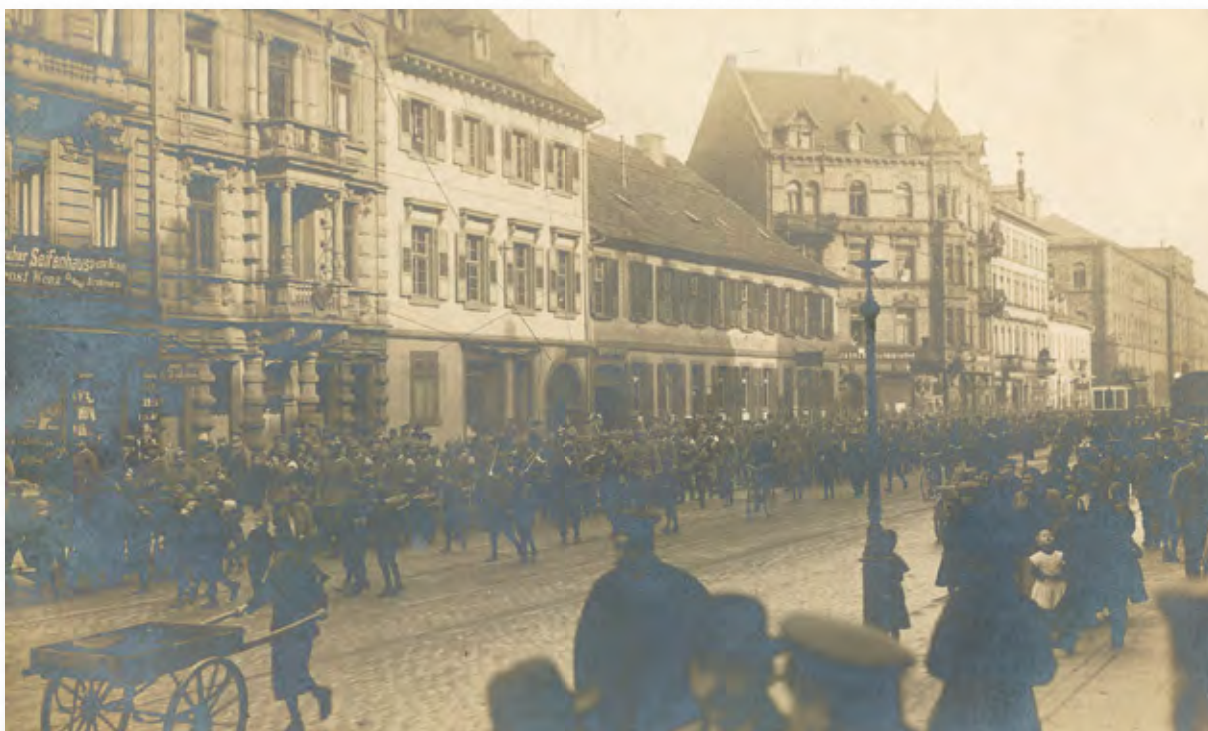
▲ Abb. 2 Abmarsch eines Infanterie-Bataillons durch die Kaiserstraße, im Hintergrund unter anderem das Gasthaus zum Laub, ganz rechts die Technische Hochschule, 1914/15
