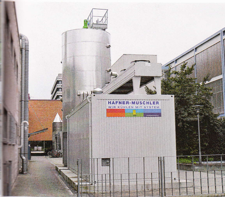
In diesem unscheinbaren Container befinden sich die Eismaschinen. Der runde Behälter im Hintergrund ist der Speicher.
